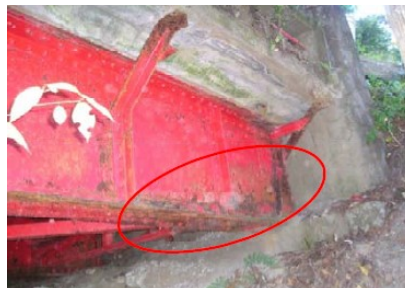
主桁の腐食
