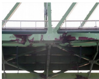
下弦材の損傷
