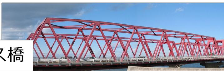
木曽川大橋：斜材 破断するも崩壊せず
