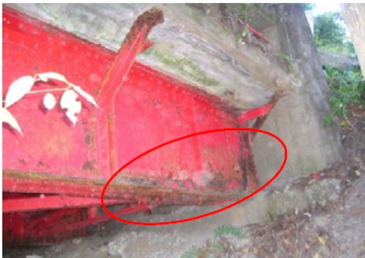
端支点部の腐食
