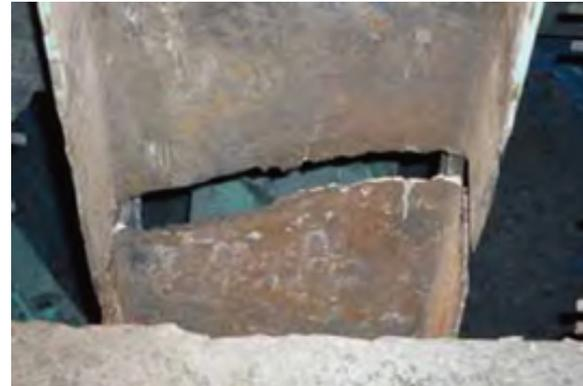
斜材の損傷
