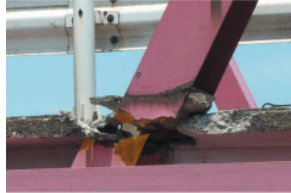
斜材の損傷
