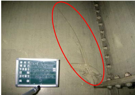
主桁に亀裂
