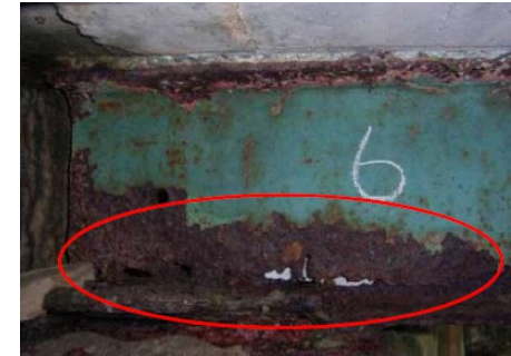
主桁が腐食
