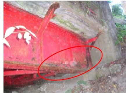
主桁が腐食
