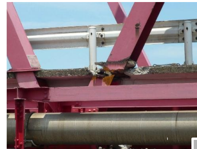
斜材の破断 (木曽川大橋)
