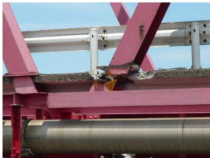
トラス橋の斜材の破断
