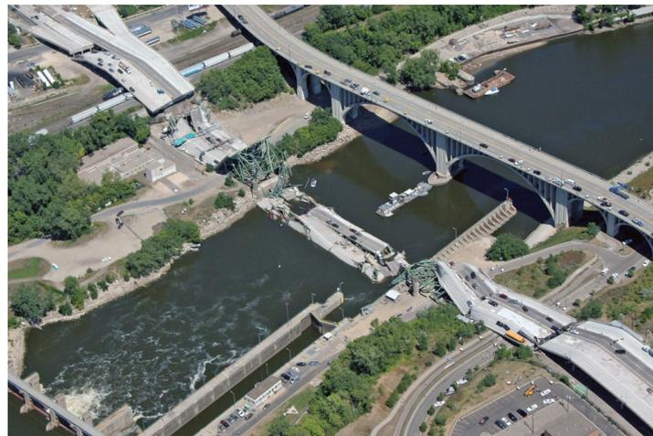
格点部の破壊が原因で橋梁全体の崩壊
